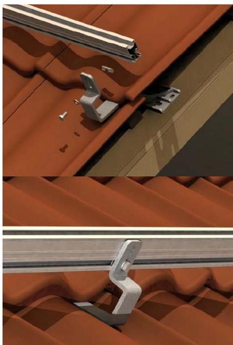
Une fois toutes les pattes fixées, montez ensuite les profilés sur la ligne de pattes, horizontalement, au moyen des écrous à rainure fournis. Chaque patte doit être fixée au profilé.
